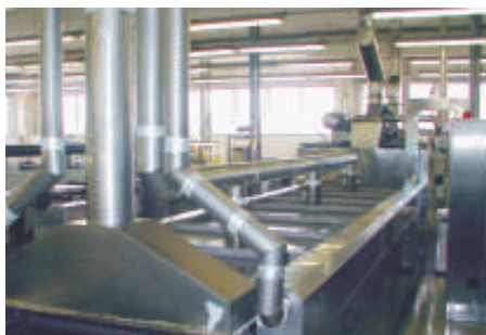
Průmyslové nádrže a zásobníky
